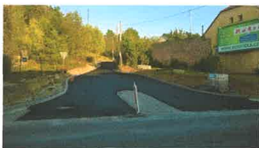
Rekonstrukce místní komunikace „Na Stráži“ 24. 9. 2016. Foto: archiv obce
