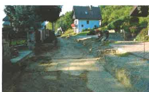
Zahájení rekonstrukce místní komunikace 14. 9. 2016. Foto: archiv obce
