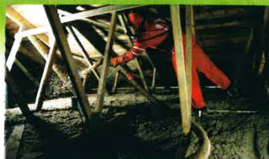
Neúnosný pohled vyžaduje opatrnost. Provedení finální vrstvy a vyrovnání na požadovanou výšku izolace.
