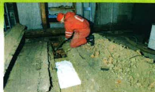
Půdu není třeba kompletně vyklízet, k izolaci postačí jen několik otvorů. Dvě přední pole jsou hotová, pracovník plní dutinu izolací.
